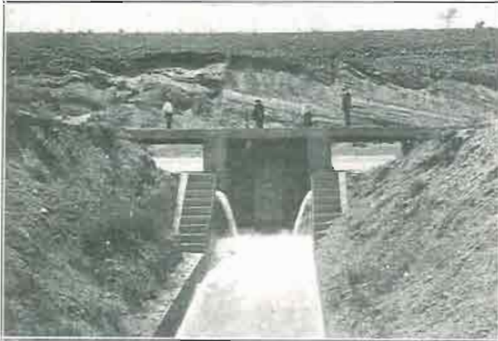
Aliviadero de superficie y compuertas de desagüe de fondo del Ramillo, año 1921
