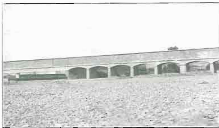
Acueducto del Cidacos, terminado. Vista parcial, 1923
