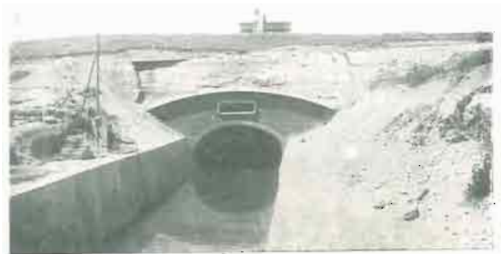
PANTANO DE LA SOTONERA. — Túnel de toma inferior
