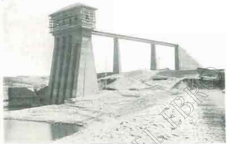
PANTANO DE LA SOTONERA. — Torreón de compuertas de la toma inferior
