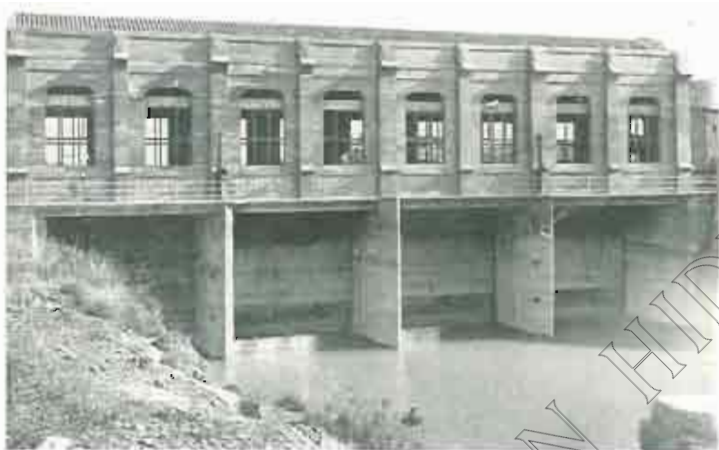
Compuertas de la Presa del Gállego
