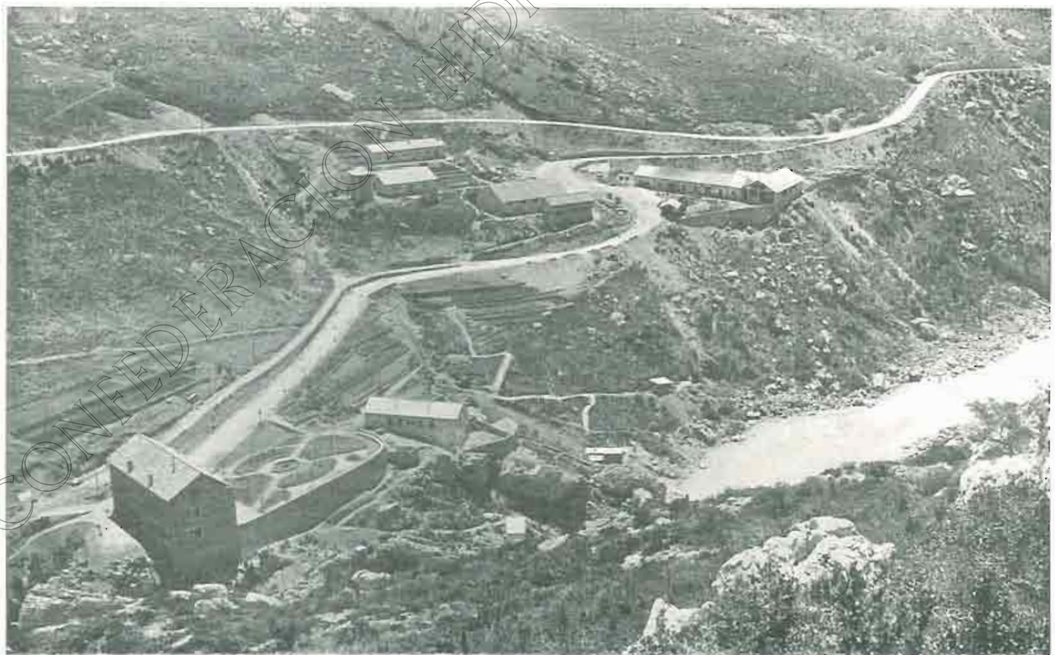
PANTANO DE BARASONA. — Casa oficina y obras accesorias (viviendas, almacenes, talleres, etc.)
