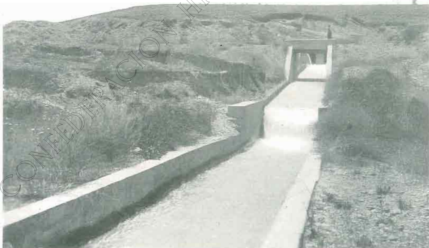
Aliviadero de superficie y compuertas de desagüe de fondo del Ramillo, año 1921
