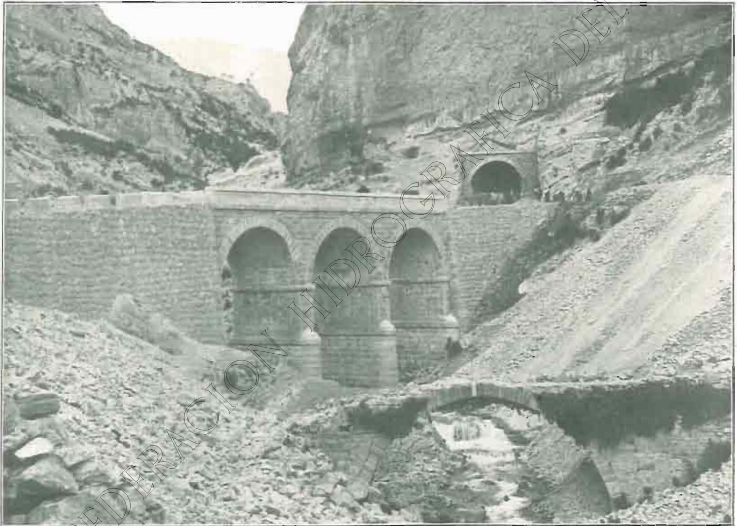
Carretera al Pantano de Arguis, puente en donde daba comienzo el peligroso paso denominado "El Escalar"
