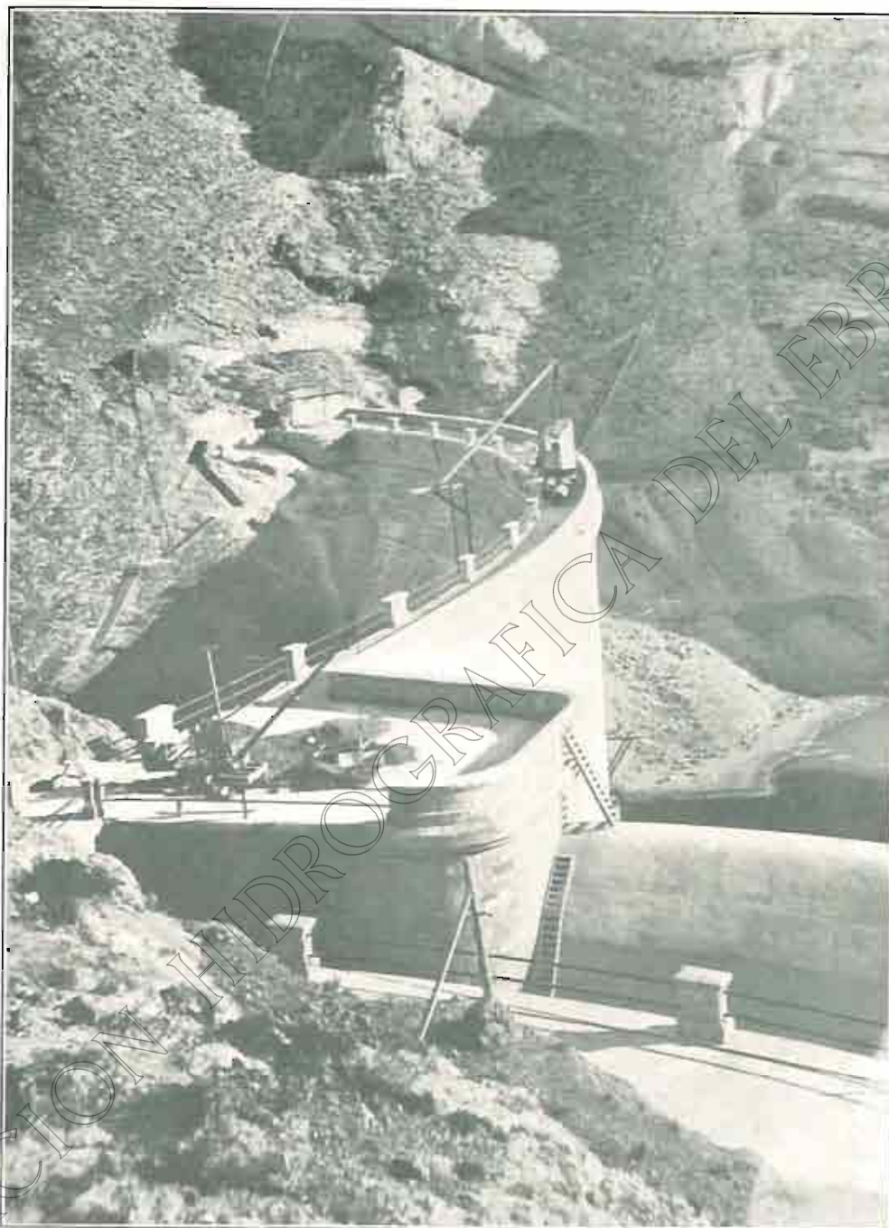
Presa de embalse, aliviadero de superficie y canal colector
