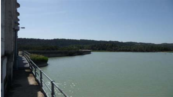
Foto 1: Presa del embalse de Búbal.
