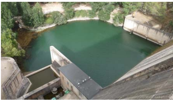
Foto 2: Vista desde la presa
