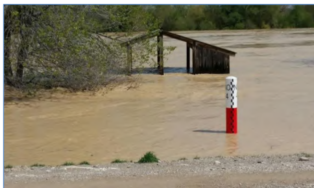
Figura 29. Crecida extraordinaria de abril 2018 en el tramo medio del Ebro. Hito en la mota defensiva de Novillas (Zaragoza).
