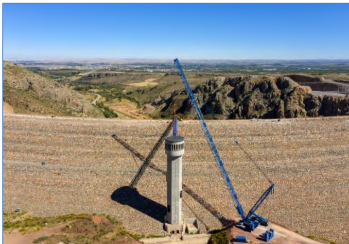
Figura 52. Vista general de la presa de Mularroya.
