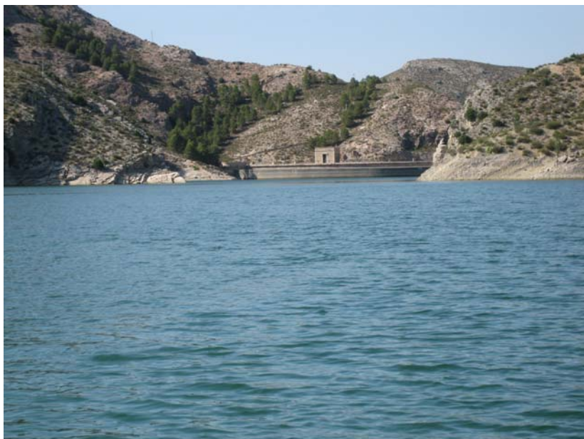
Foto 1: Vista de la presa embalse
