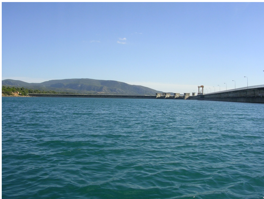
Figura 7. Vista de la presa del embalse
