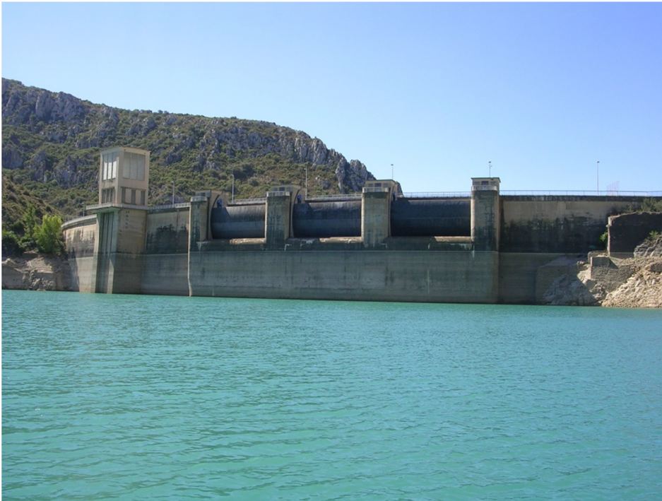
Figura 7. Vista de la presa del embalse
