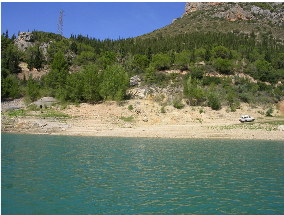
Figura 8. Vista del punto de acceso al embalse
