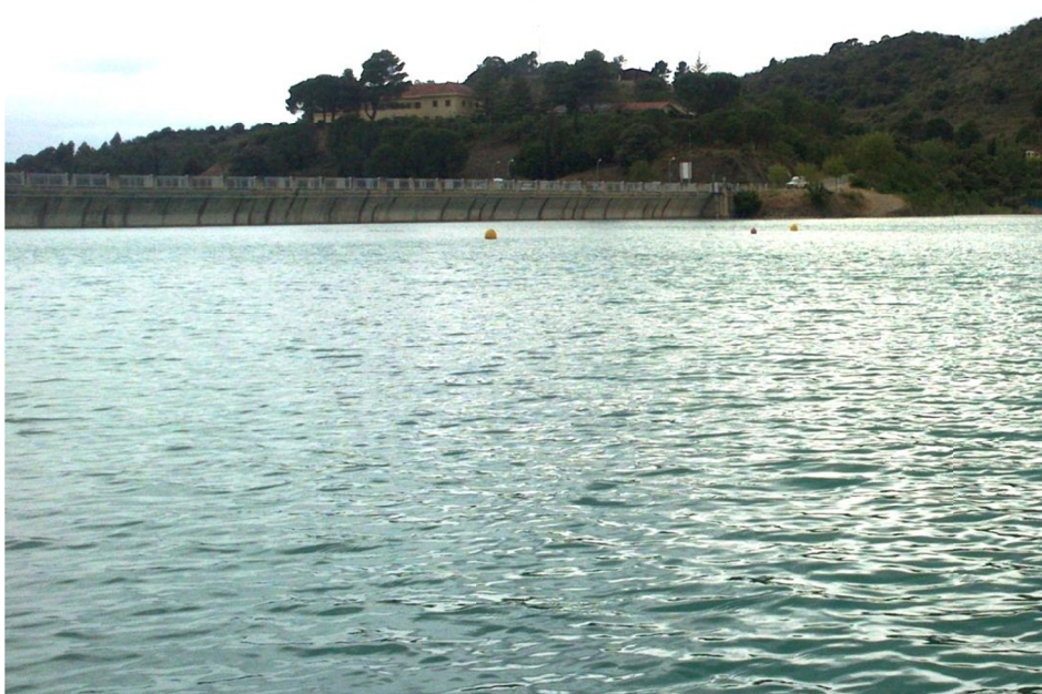
Figura 7. Vista de la presa del embalse y punto de acceso
