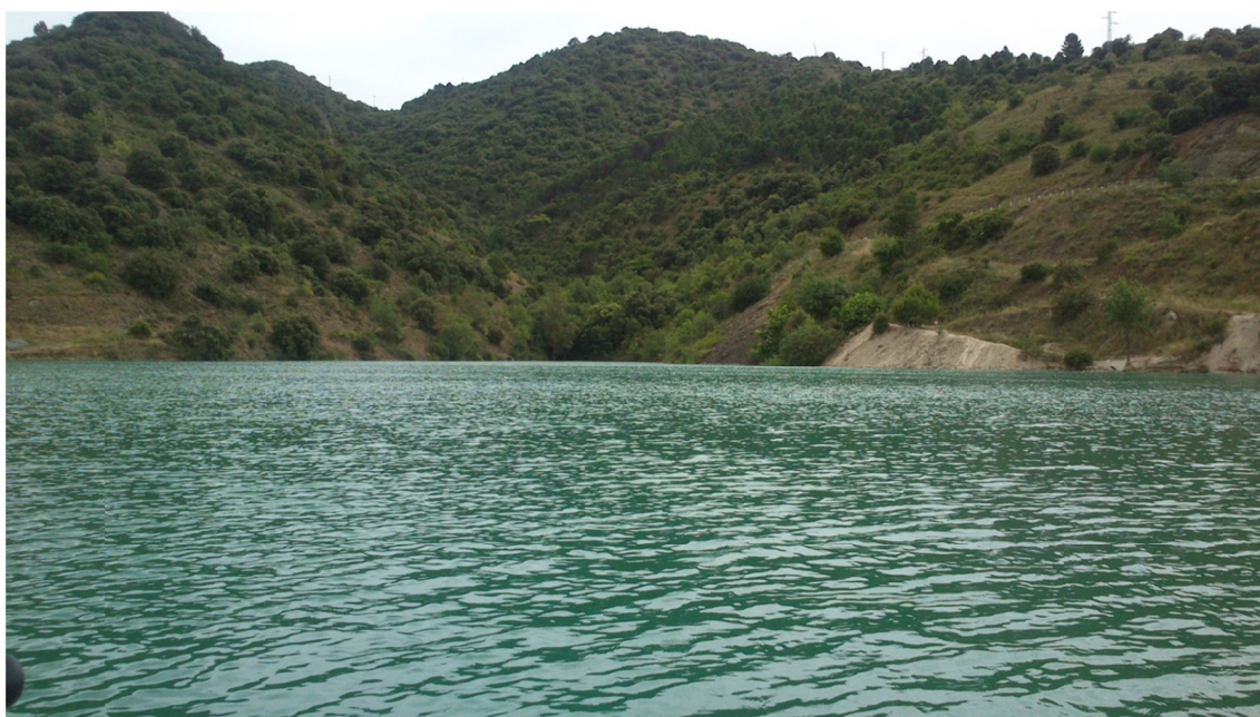
Figura 8. Vista de la cola del embalse
